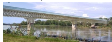
Ricostruzione del nuovo ponte sul Po
